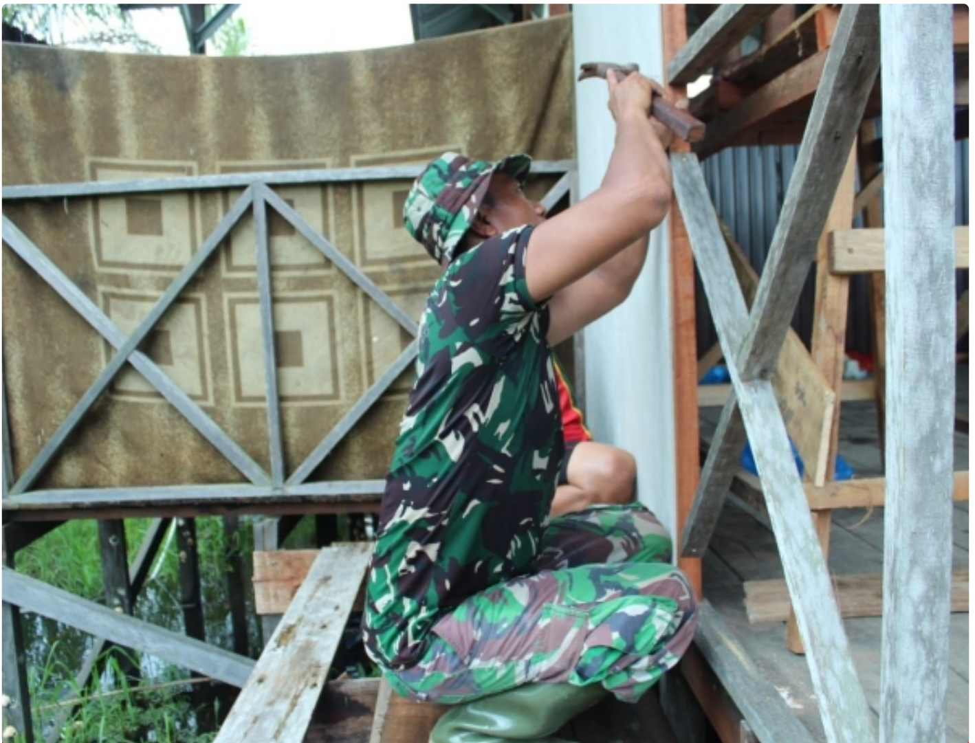
Rehap Balai Pertemuan di Lokasi TMMD 115 Capai Tahap Pemasangan Dinding Kalsiboard
